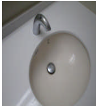
【カーンのない水道】
